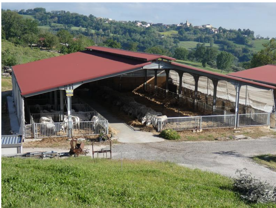
Figura 3.8 – Stalla a due falde con fessura di colmo provvista di cupolino
